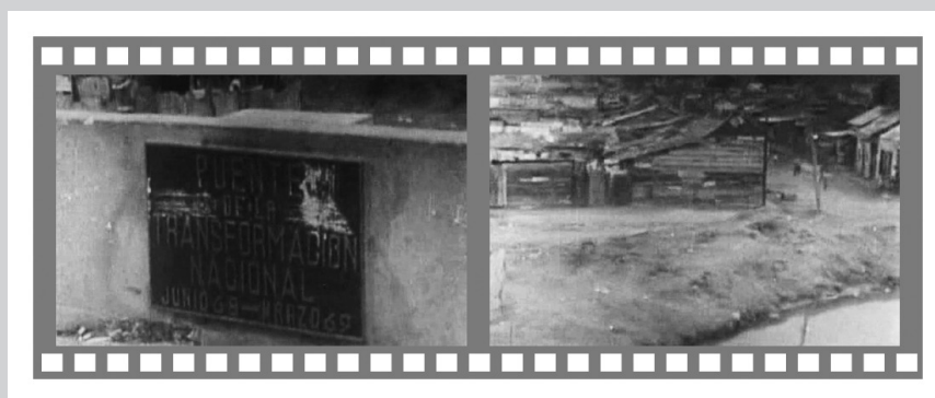
Figura 14. Dentro de un mismo plano se genera un paralelismo con el propósito de contrastar el nombre del puente —Puente de la Transformación Nacional— con las viviendas marginales ubicadas en la orilla del río. Fotogramas del documental Los hijos del subdesarrollo de Carlos Álvarez, 1975 (16 mm, blanco y negro, 45 minutos).
